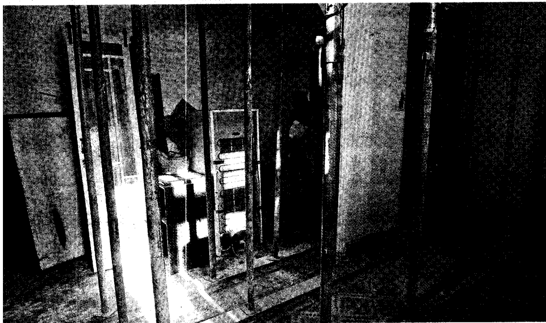
Piso apuntalado en la calle Escalante que sale a subasta. :: DAMIÁN TORRES
